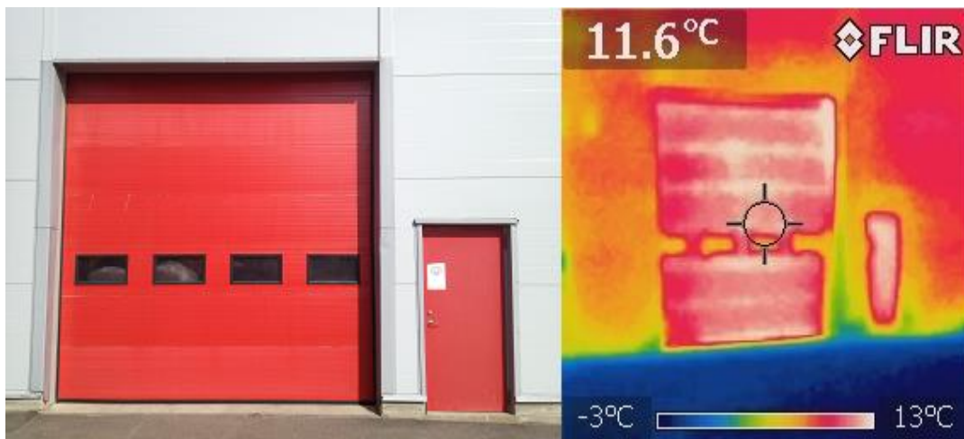
Figur 10 Port och dörr södervägg Zon 3.
