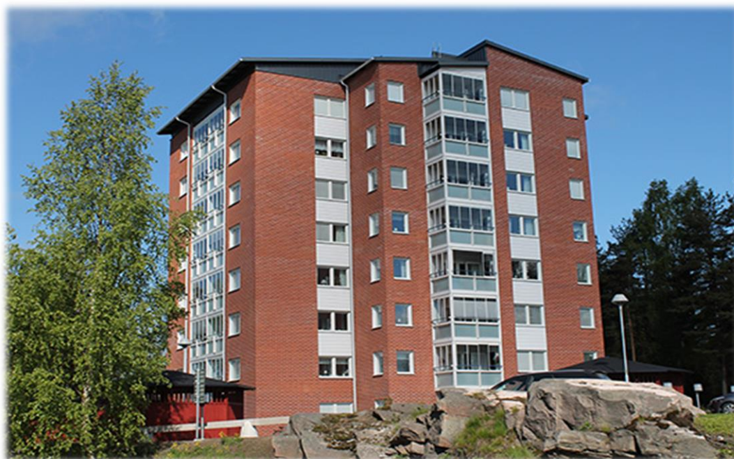
Figur 4. Kv. Pannan, NCC Folkboende
