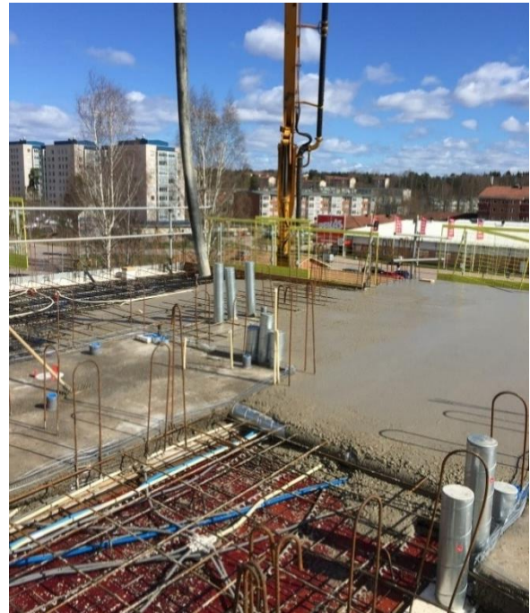
Figur 16. Betonggjutning med pump
