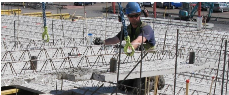
Figur 12. (Svenskbetong). Filigranbjälklag även kallat för plattbärlag.
