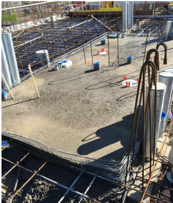
Figur 15. Sträckmetall runt badrum
