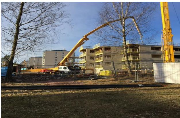
Figur 10. Gjutning av valv med mobilpump på NCC Björnparken
