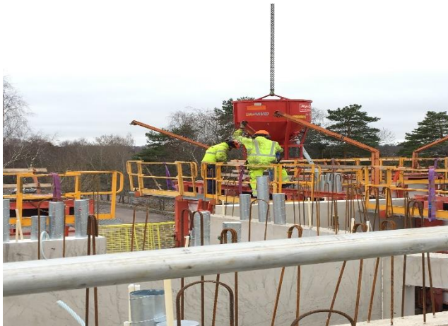
Figur 11. Väggtjutning med basker och kran
