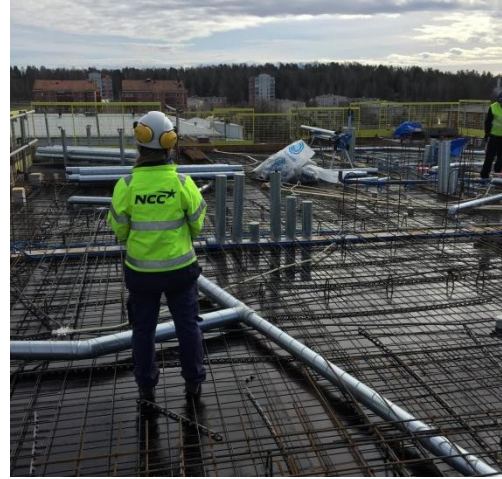
Figur 14. Underarmering med installationer
