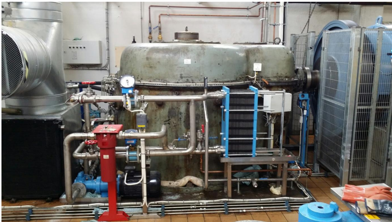
Figur 9: Bild på växellådan som i dagsläget sitter i Rexeds kraftstation.
